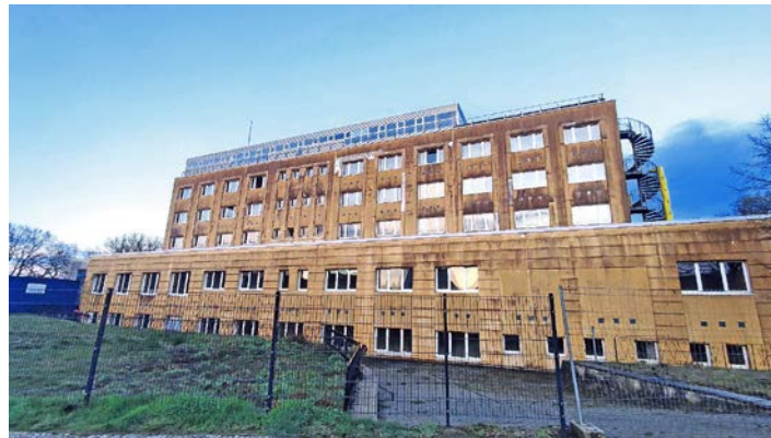
Auch dieses verlassene Hotel in Flecken Zechlin soll künftig als Flüchtlingsheim genutzt werden. Die Umbauarbeiten gehen nur langsam voran
